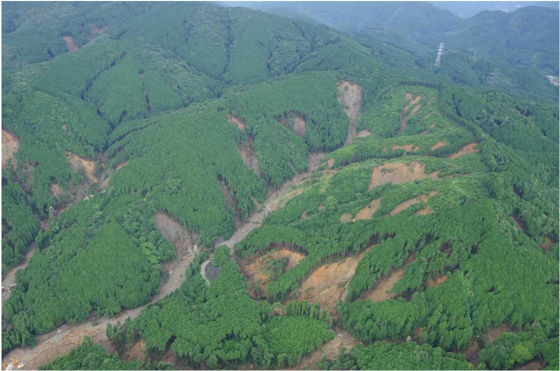
写真1 朝倉市の崩壊現場
