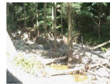
流木化する可能性の高い立木の伐採
