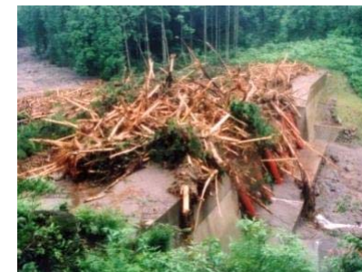
流木捕捉式治山ダムの設置
