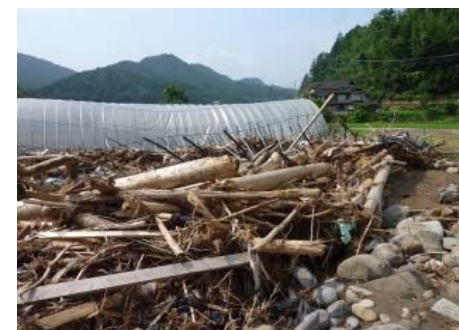
流木の堆積状況
