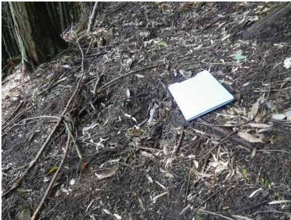
源頭部上部の亀裂
