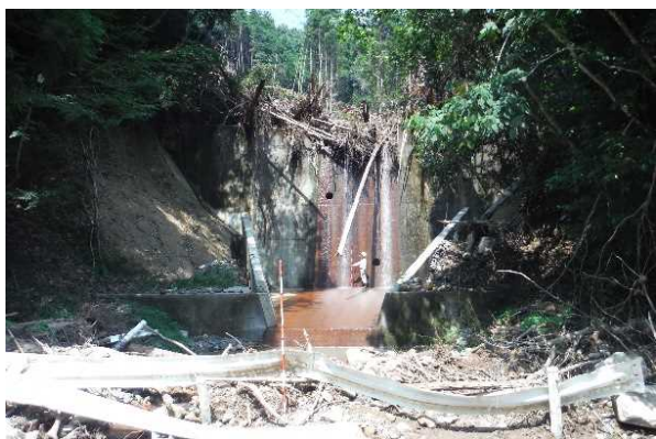
治山ダム全景
