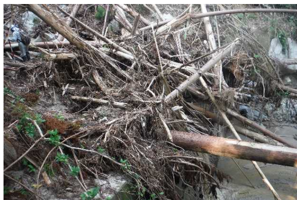
治山ダム（3 基目）堆砂域の状況
