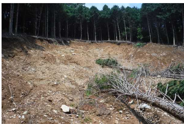
崩壊箇所源頭部
