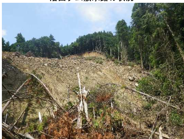
治山ダム上流の状況
