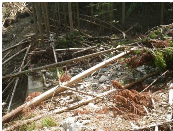
治山ダム（3期目）堆砂域の状況
