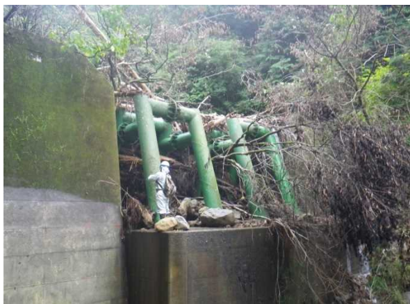
透過型治山ダム（建）全景
