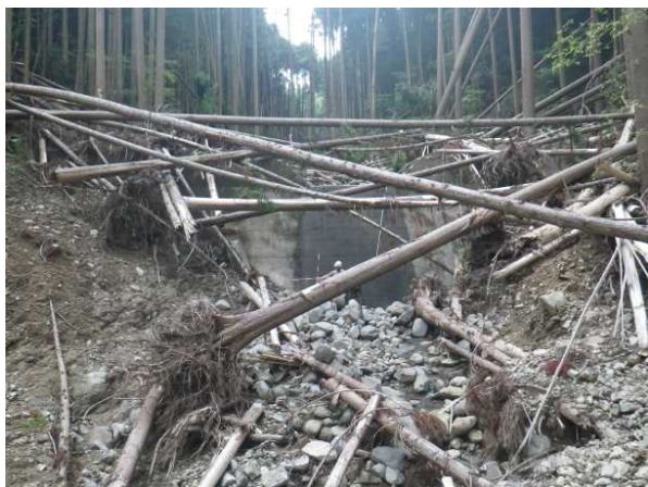
治山ダム（3基目）全景
