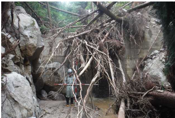
治山ダム（4基目）全景
