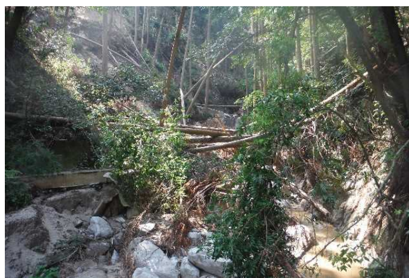
治山ダム（1 基目）堆砂域の状況
