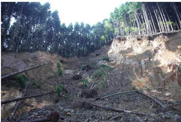
崩壊箇所源頭部
