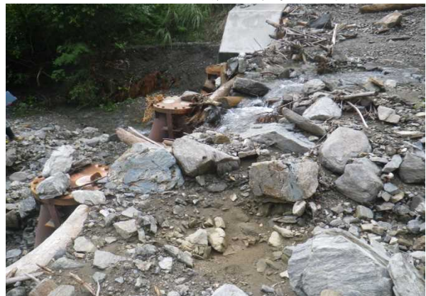
透過型治山ダム（箸立）堆砂域の状況
