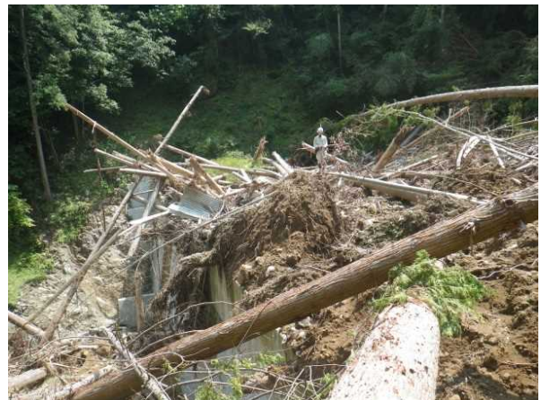
治山ダム（1 基目）堆砂域の状況
