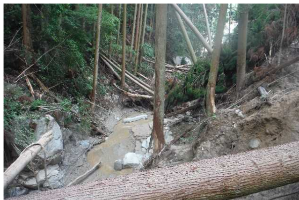
治山ダム（2 基目）堆砂域の状況
