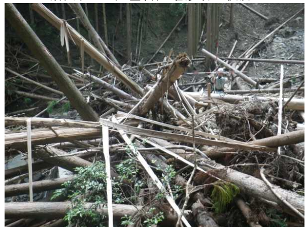
治山ダム（2 基目）堆砂域の状況
