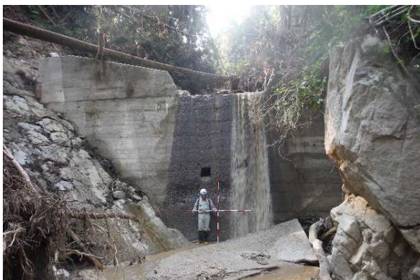
治山ダム（2 基目）全景
