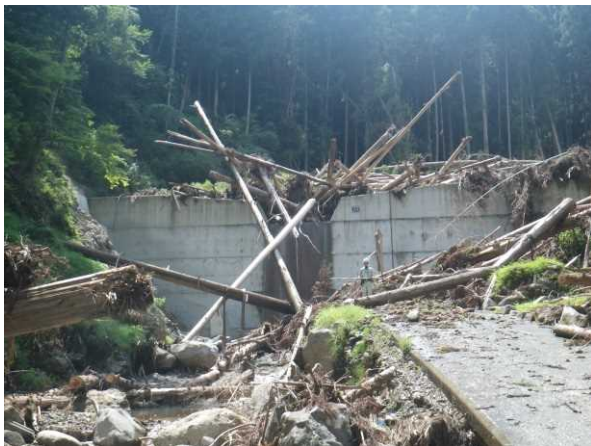
治山ダム（1 基目）全景
