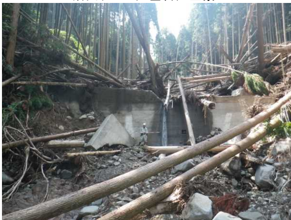
治山ダム（2 基目）全景
