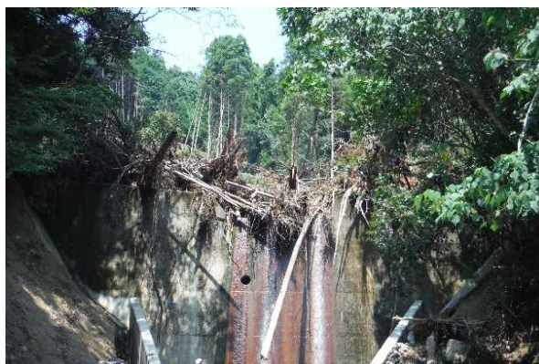
治山ダム放水路の状況
