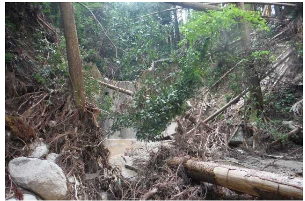
治山ダム（4基目）堆砂域の状況
