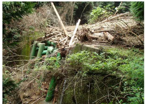
透過型治山ダム（建）堆砂域の状況
