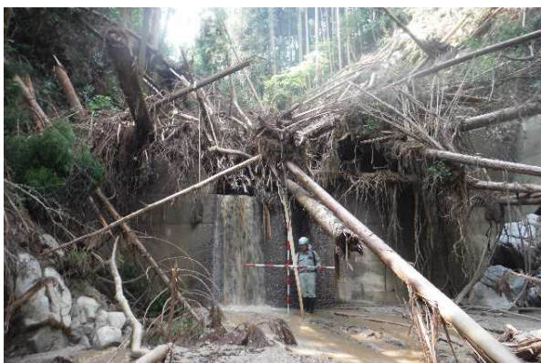
治山ダム（3 基目）全景
