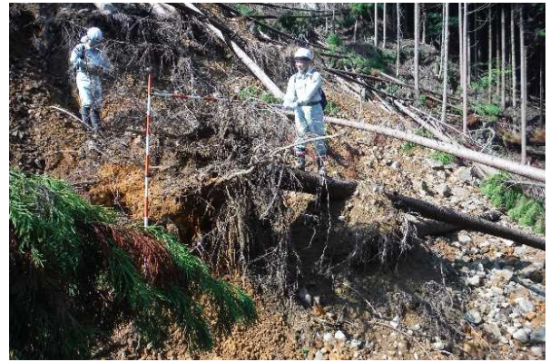
崩壊地内の倒木の根系
