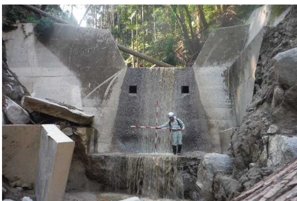
治山ダム（1 基目）全景
