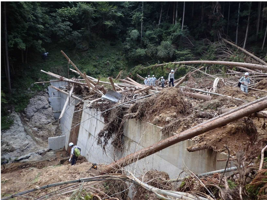
治山施設(不透過型の治山ダム) の流木捕捉状況(猿喰地区)
