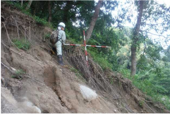
崩壊地内縁の根系（広葉樹）
