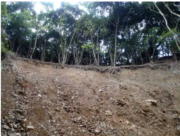
広葉樹林の崩壊箇所源頭部
