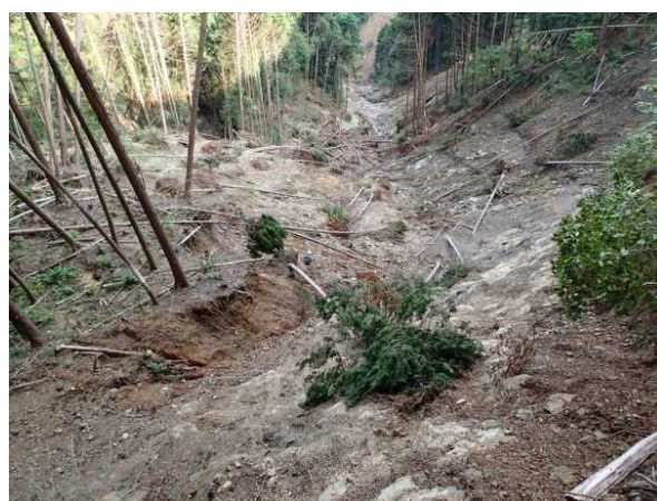
崩壊箇所源頭～下方
