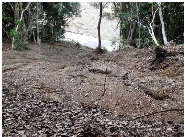
広葉樹林の崩壊箇所源頭～下方
