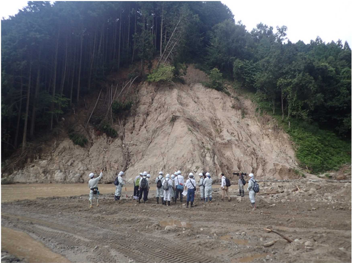
崩壊地の状況(全景)(真竹地区)
