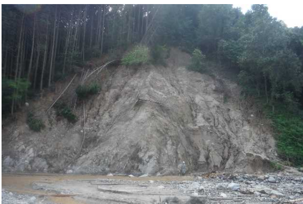
崩壊箇所全景
