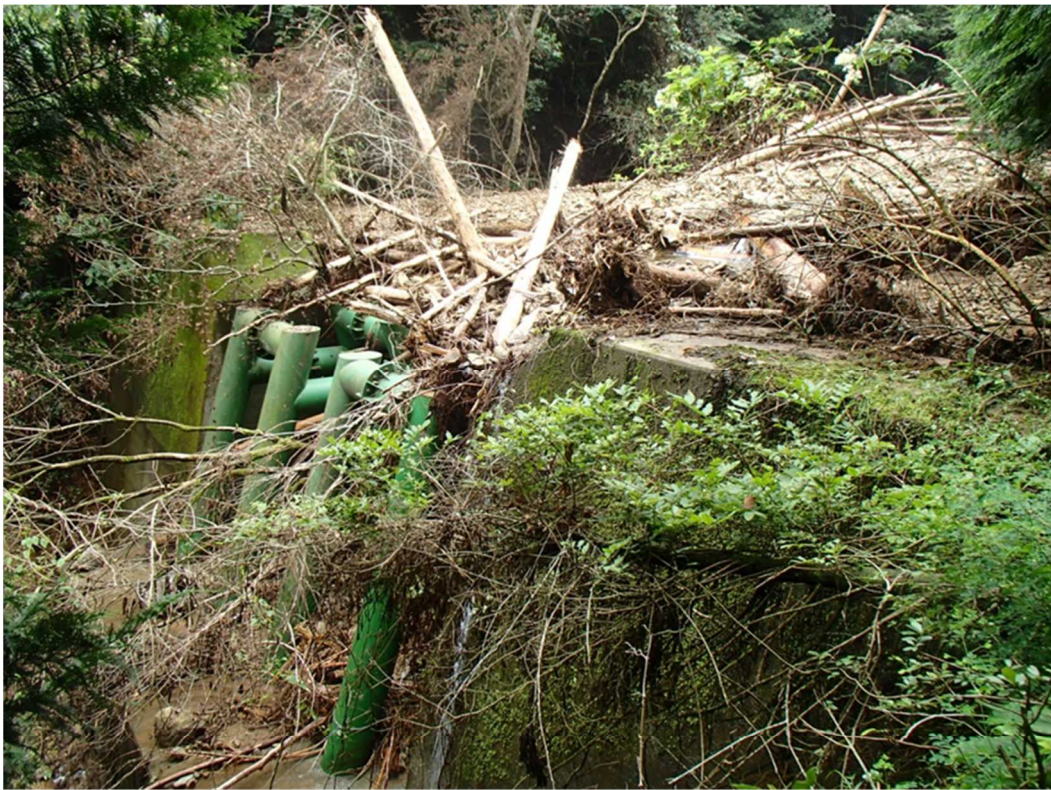
治山施設(透過型治山ダム)の 流木捕捉状況(佐田地区)
