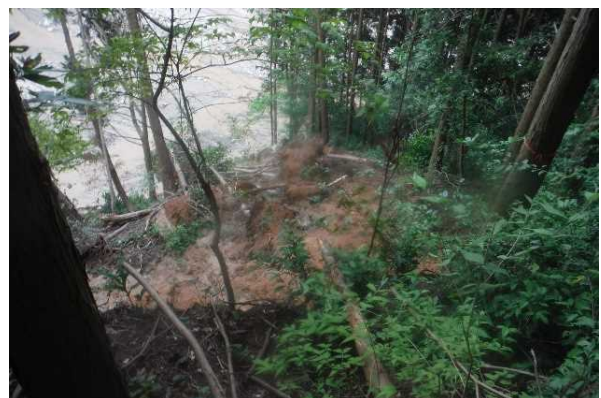
崩壊箇所源頭～下方
