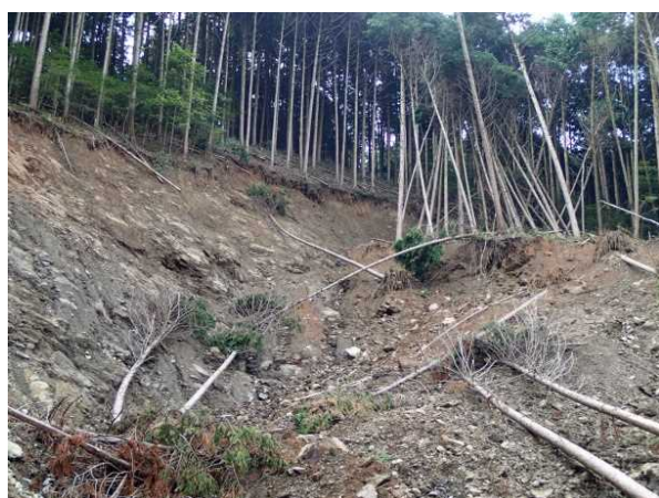
崩壊箇所源頭部
