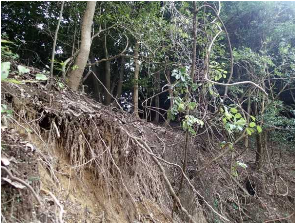
崩壊地内縁の根系
