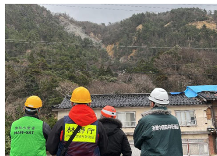
MAFF-SATによる 現地調査 (1/12・輪島市)
