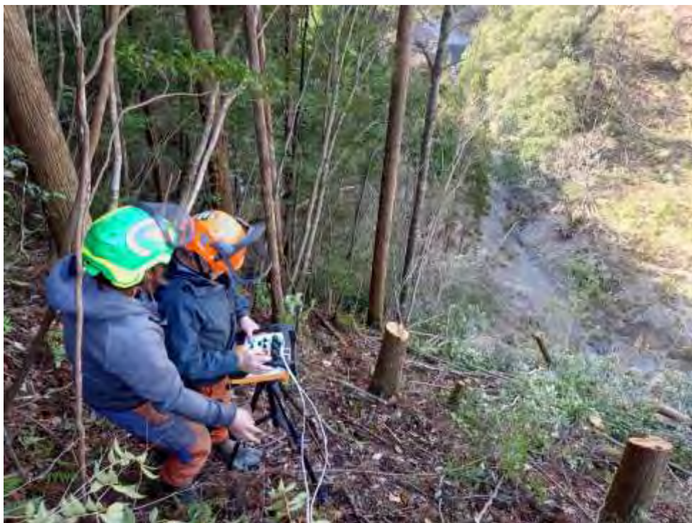
写真－9 林内にコントローラをもちこみ、近接目視で作業
