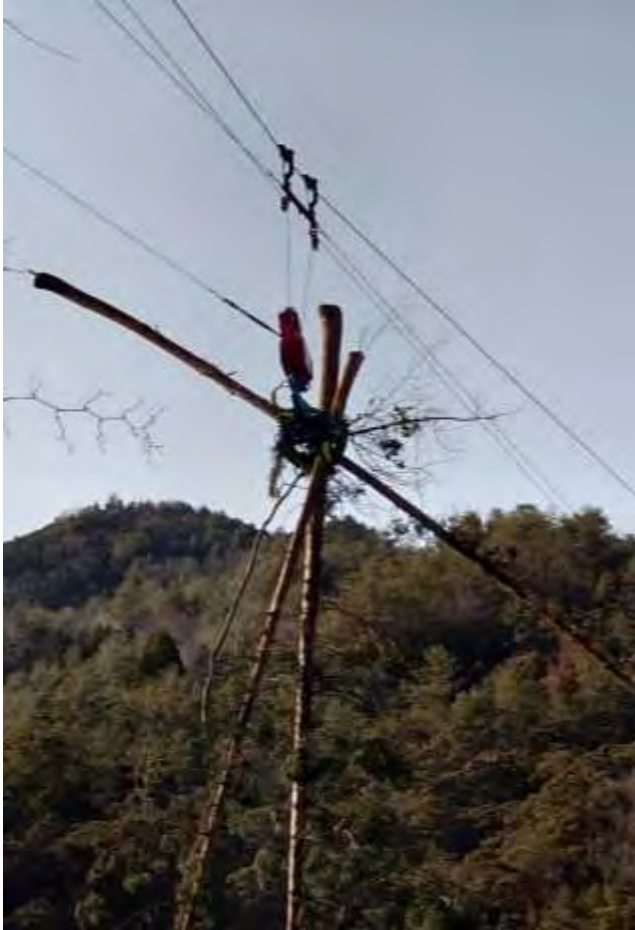
写真－8 架線グラップルの「鷲づかみ」
