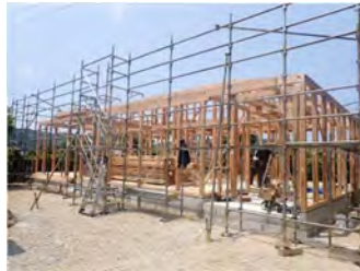
図 19 ながと型住宅建て方現場
