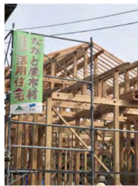
図3 ながと型住宅建て方現場
