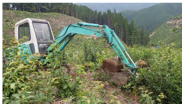
(道から現場への法面が登れず、バックホウで進入口を作設)
