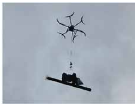
ドローンによる防護柵の運搬
