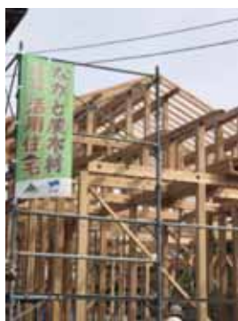
図 3 ながと型住宅建て方現場
