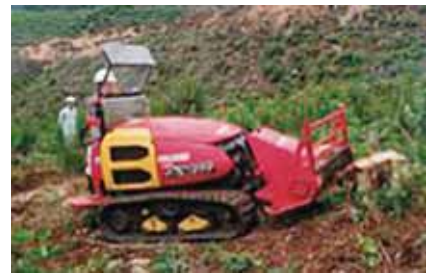
乗用刈払機による伐根処理
