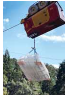
資機材の吊り下げ
