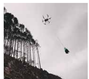
ドローンによる資機材運搬
