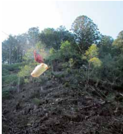
架線を利用した資機材運搬
