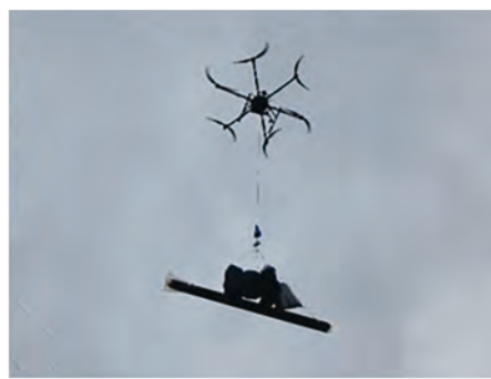
ドローンによる防護柵の運搬
