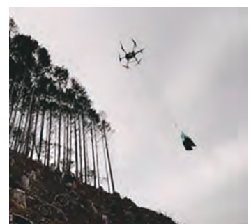
ドローンによる資機材運搬
