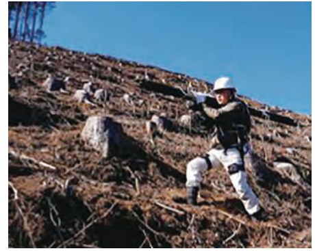
アシストスーツを着用した資機材運搬
