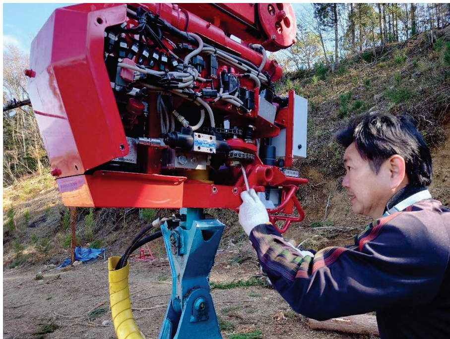
写真 2-2-12 グラップルの旋回部分の緊急修理
