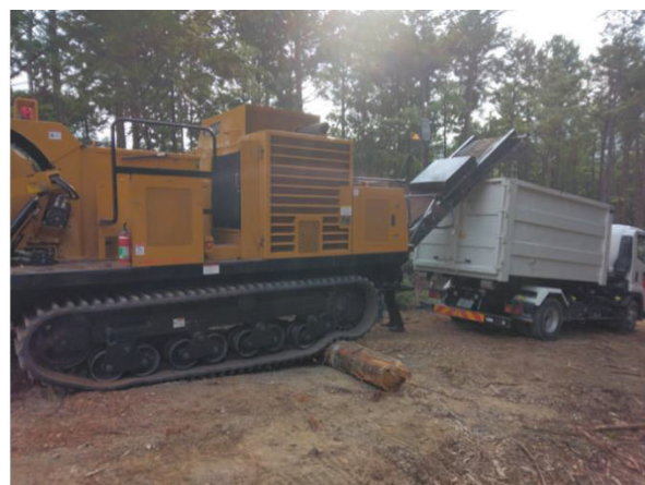
丸太敷設による排出口の高さ調整
