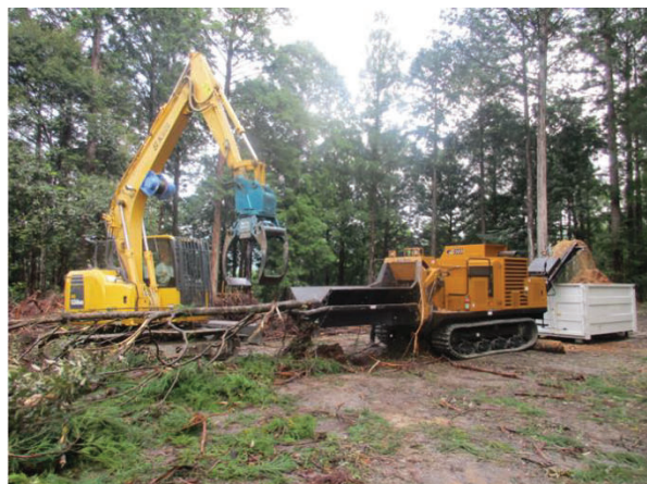
全木材の破砕作業実施状況
