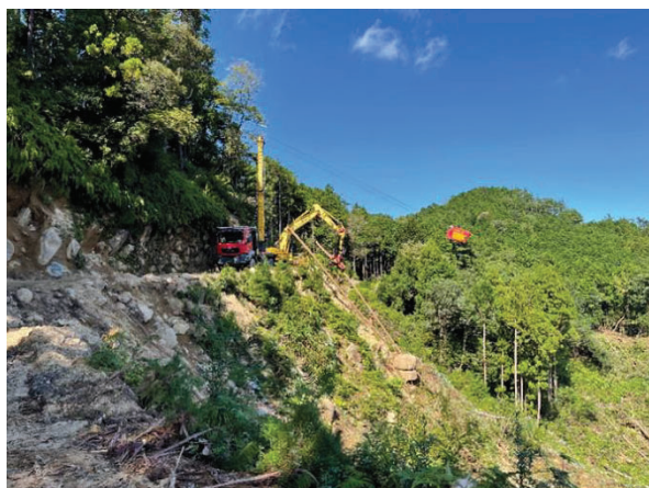
上げ荷集材実施状況
