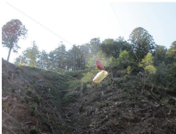
タワーヤードによる再造林資器材運搬作業状況
