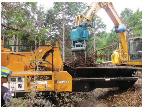
林地残材(末木・枝条)の破砕作業実施状況
