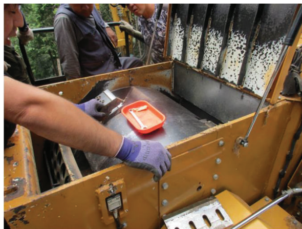
現場での切削刃交換作業実施状況
