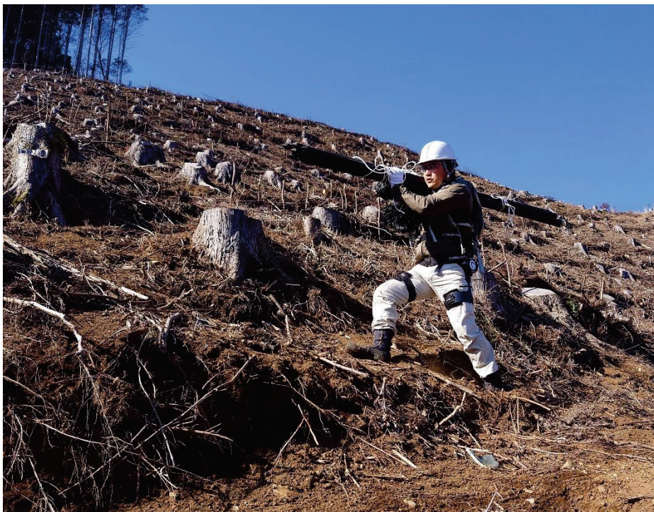
写真 2-2-24 アクティブスーツ HAL を使用したシカ柵資材の搬入作業
