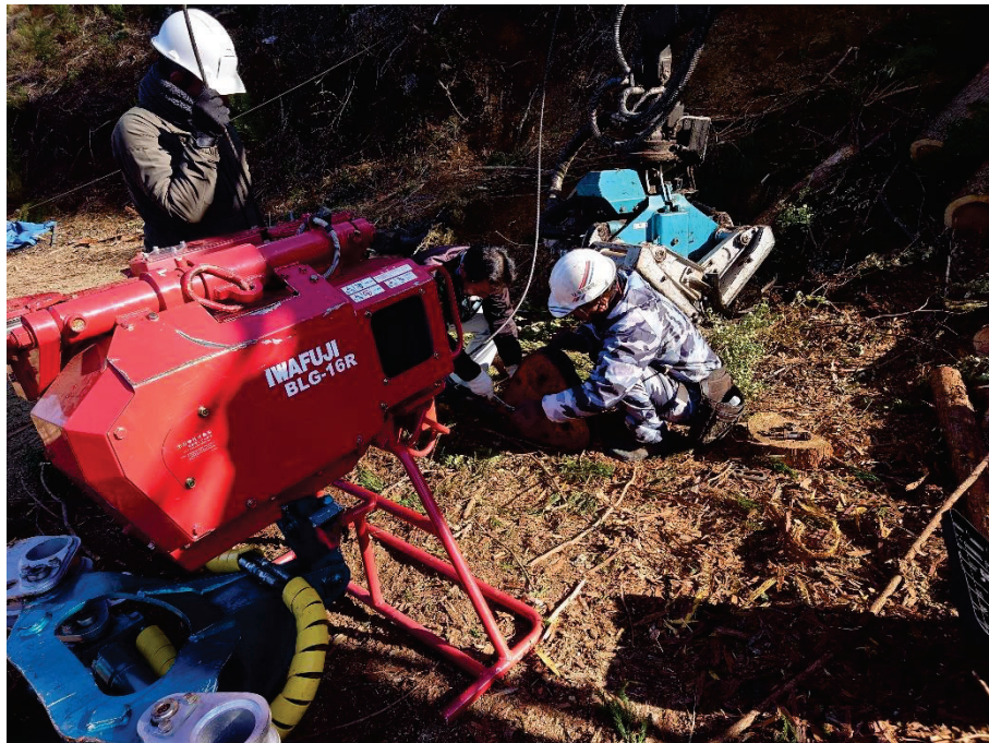
写真 2-2-9 ローチンへの切り替え作業
