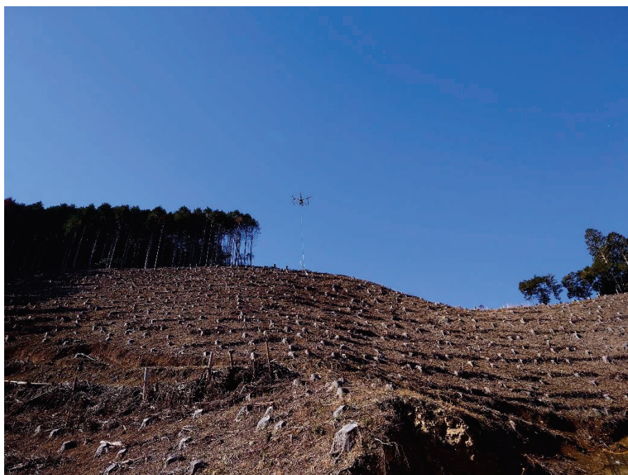
図 2-2-22 同じくシカ柵資材の尾根筋への運搬作業
