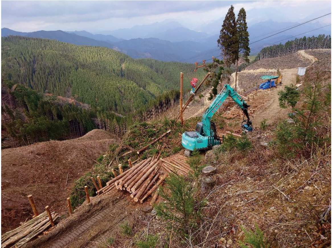
写真 2-2-8 実証試験地の全景
