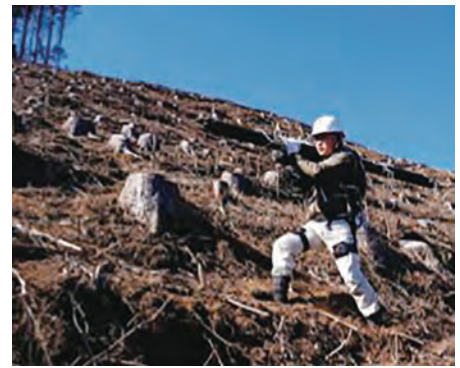
アシストスーツを着用した資機材運搬
