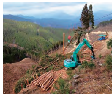
架線集材作業
