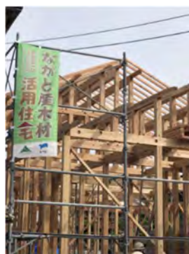
図 3 ながと型住宅建て方現場
