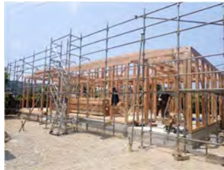
図 19 ながと型住宅建て方現場
