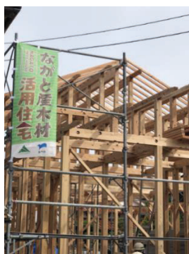
図 3 ながと型住宅建て方現場
