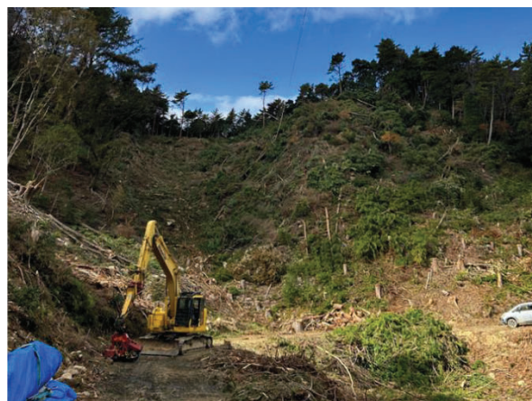
下げ荷集材実施状況
