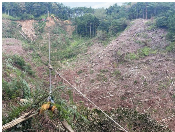
皆伐での張替作業実施状況
