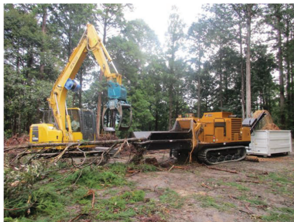
全木材の破砕作業実施状況
