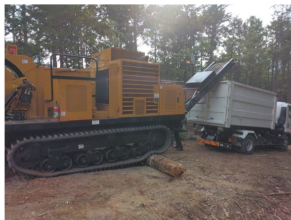
丸太敷設による排出口の高さ調整
