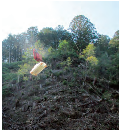
架線を利用した資機材運搬
