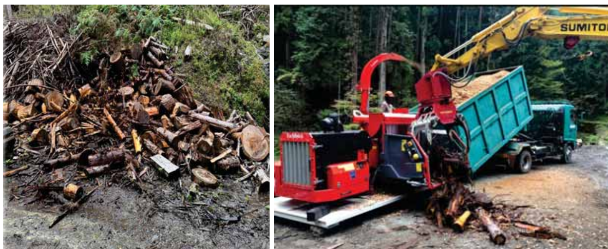
川股実証地の林地残材(左)、及び移動式チップパーを活用した林地残材の現地チップ化
