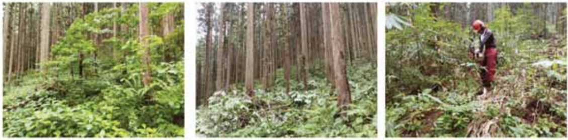
図 15 対象地伐採前(左)伐採後(中央)及び作業中の様子(右)
