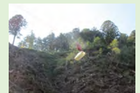
タワーヤーダによる資機材運搬
