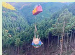
架線を活用した獣害対策資材の荷上げ
