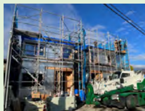
大型パネルによる建築
