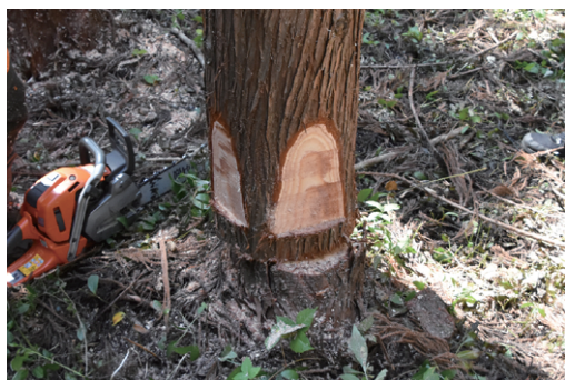
フェイスカットを施した状況
