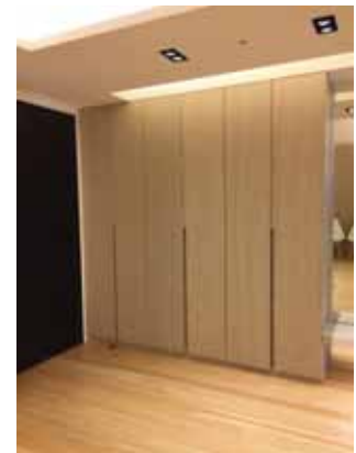
桧フローリング施工の様子
