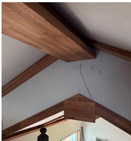
断熱材を入れた後の状態（内装）
