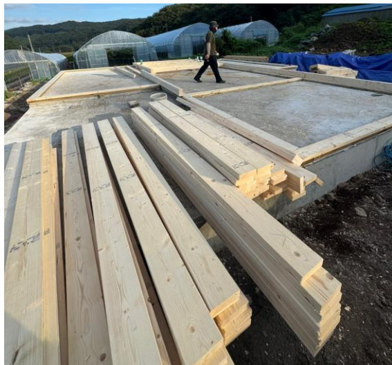
基礎工事の様子
