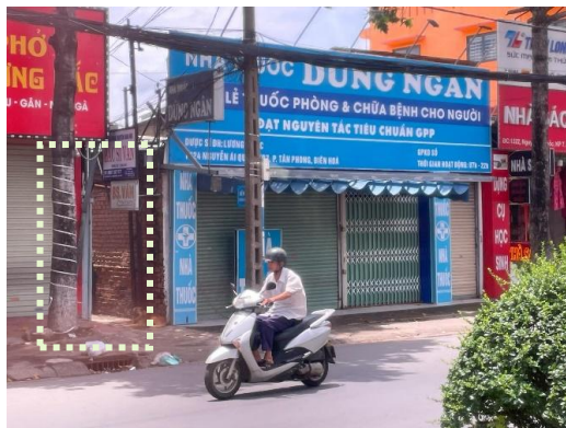
レンガ積みの建物、側面でレンガを視認
