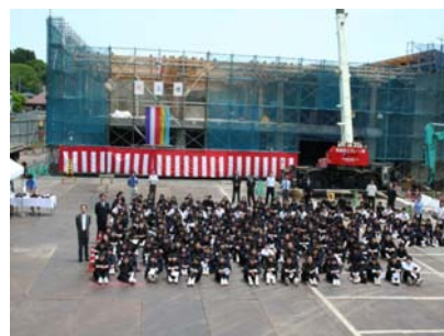
生徒全員参加による上棟式
