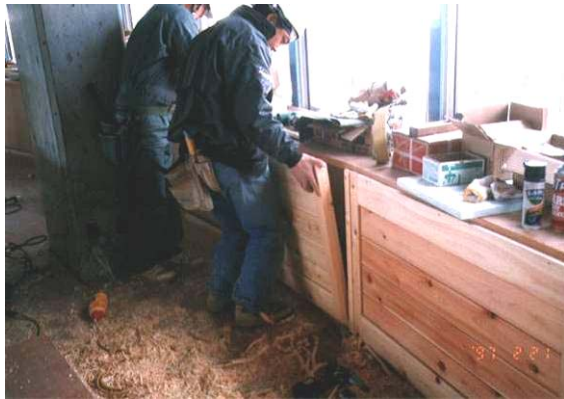
ハーフパネルの施工
