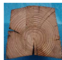
写真-2 カラマツ製遮音板部材断面 (30年経過時)
