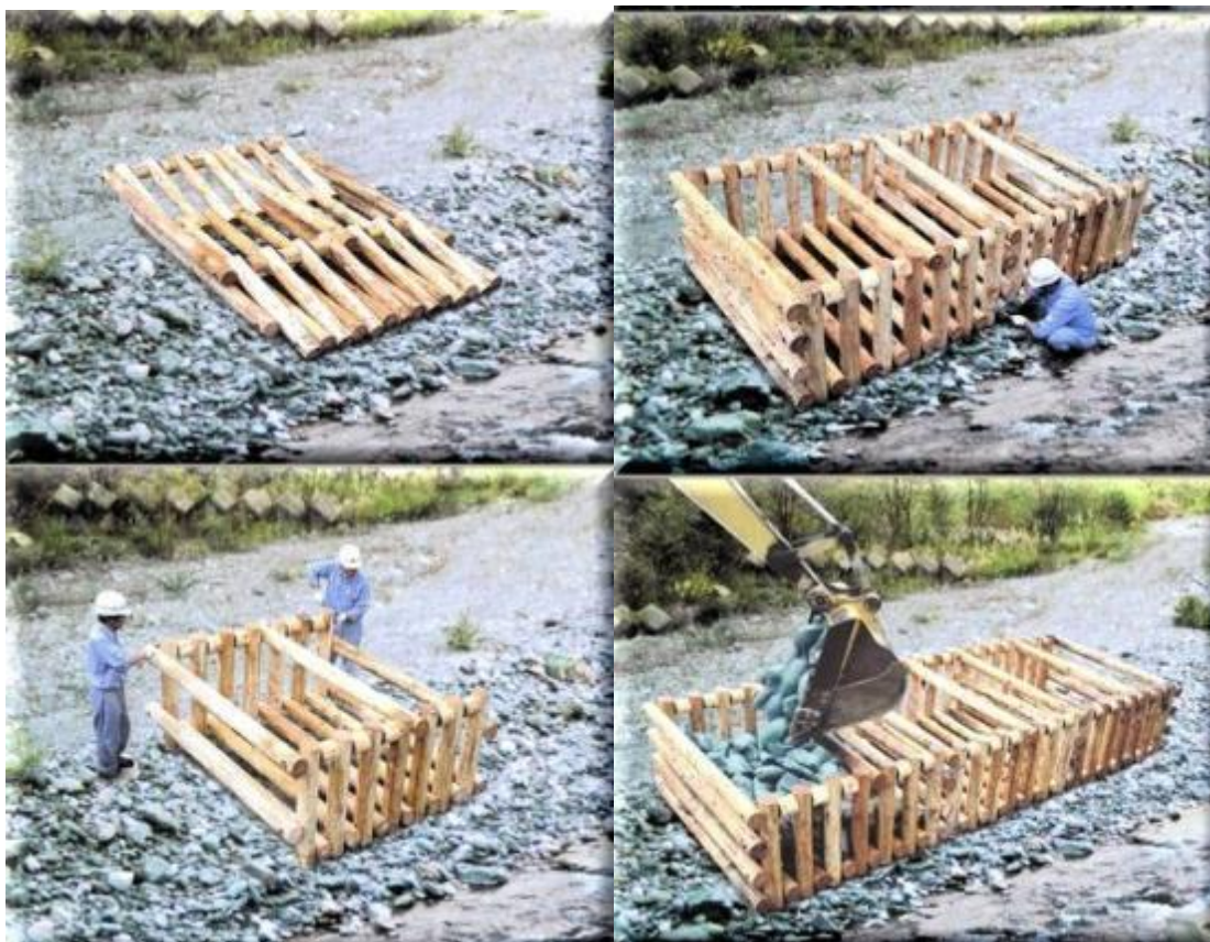
図 3-149 ナチュラルウッドによる施工方法 (左上：起立→左下：設置→右上：連結→右下：中詰)
