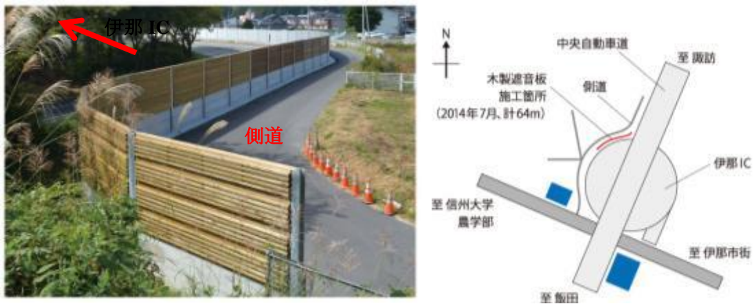
図 3-135 長野県における木製遮音壁の施工例（中央自動車道の伊那 IC）
