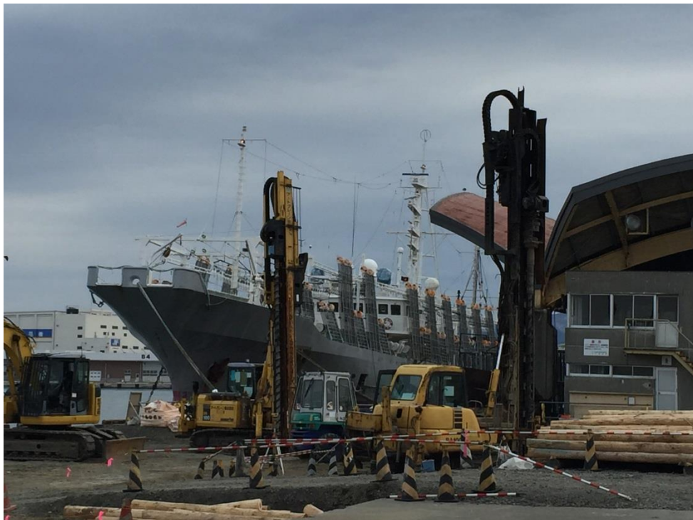
図 3-129 飛鳥建設による丸太打設工事の様子（八戸市、平成 27 年 12 月撮影）
