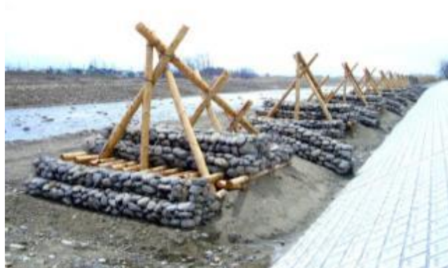
図 3-159 国土交通省甲府河川国道事務所が笛吹川に設置した聖牛 (平成 18 年 4 月)
