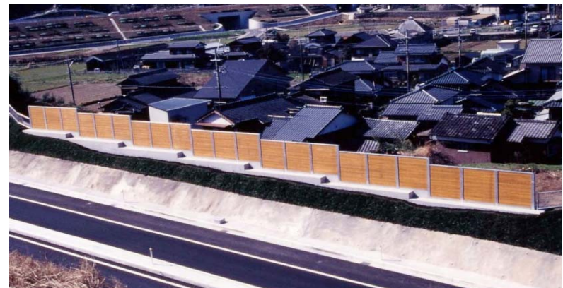
D. 木製遮音壁
