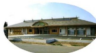
木造公共施設
