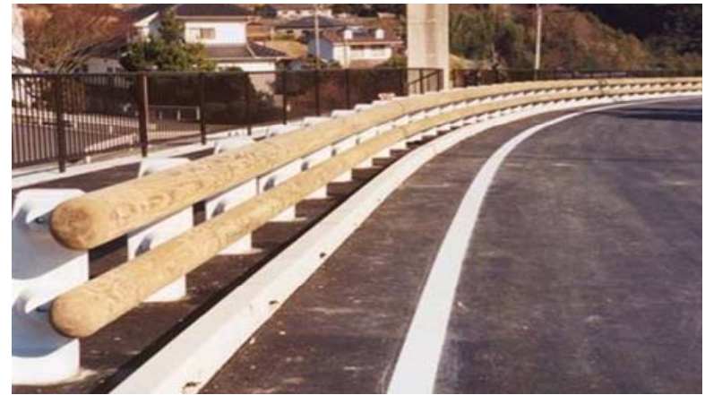
B. コンクリート支柱、スギ(円柱加工)
