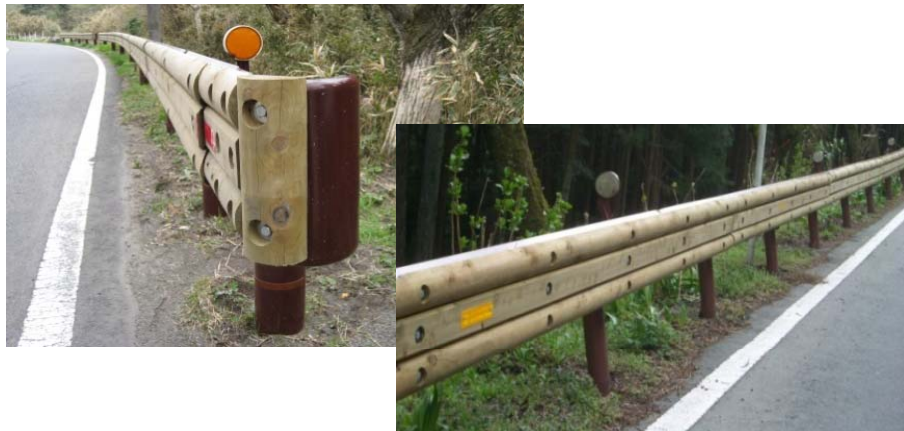
C. 既存の鋼製ガードレールに固定、スギ(製材加工)
