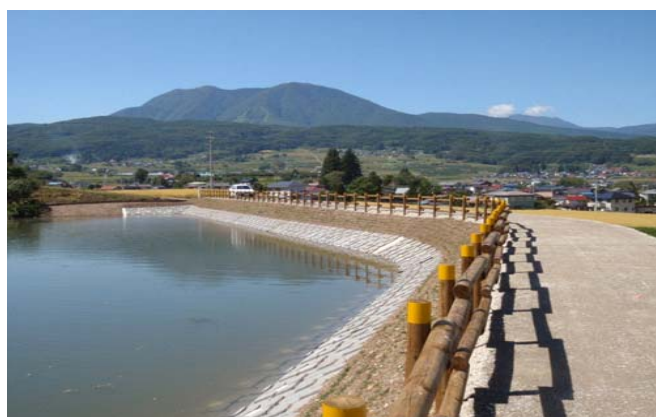
ため池等整備事業による転落防止柵 (長野県上水内郡)
