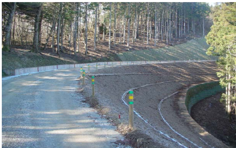
林道事業の視線誘導標（徳島県勝浦郡）
