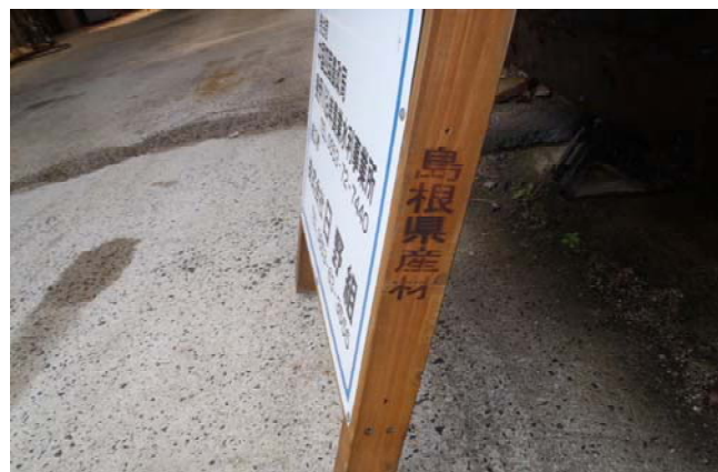
事業の標識工（島根県出雲市）
