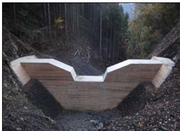
治山工事の残存型枠（山梨県南巨摩郡）
