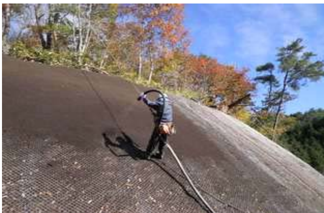
チップの植生基材吹付工
