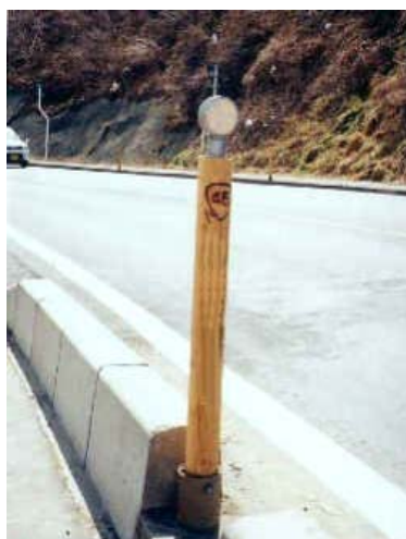
視線誘導標の例
