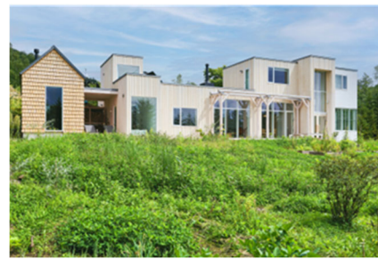
令和6年3月に竣工した木造の宿泊施設 「MAISON SHIRO」
