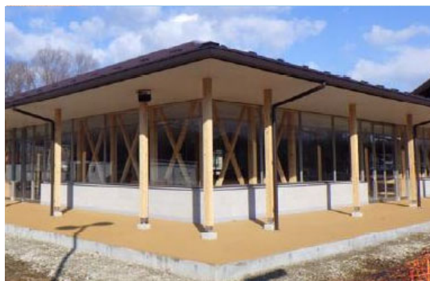
道の駅那須高原友愛の森 新館 農産物直売所 (栃木県那須郡那須町)〔農山漁村振興交付金〕 ※栃木県産材等を活用
