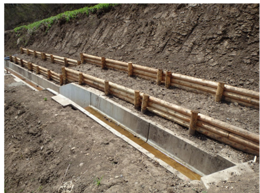
丸太筋工 (長野県上水内郡飯綱町) [県営農村地域防災減災事業]
