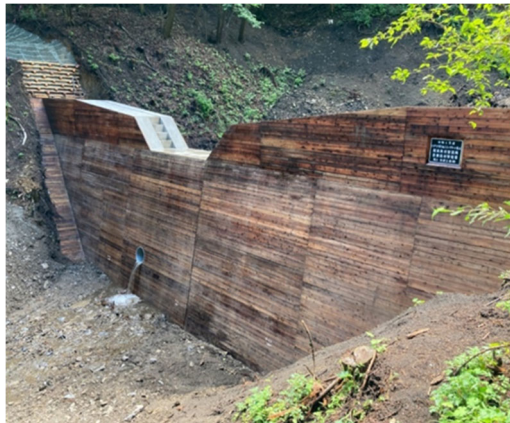
木製残存型枠 (群馬県吾妻郡東吾妻町) [国有林治山事業]
