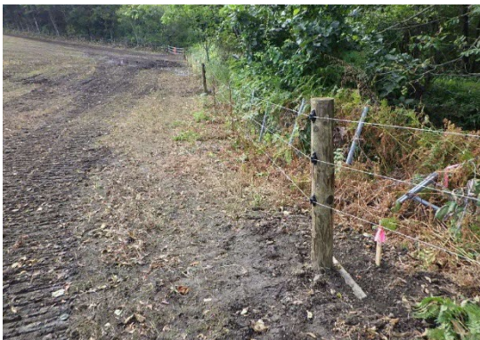
隔障物柵工（北海道芽室町） [草地畜産基盤整備事業]
