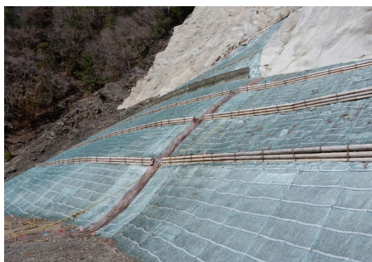
丸太筋工 (奈良県吉野郡十津川村) [民有林直轄治山事業]
