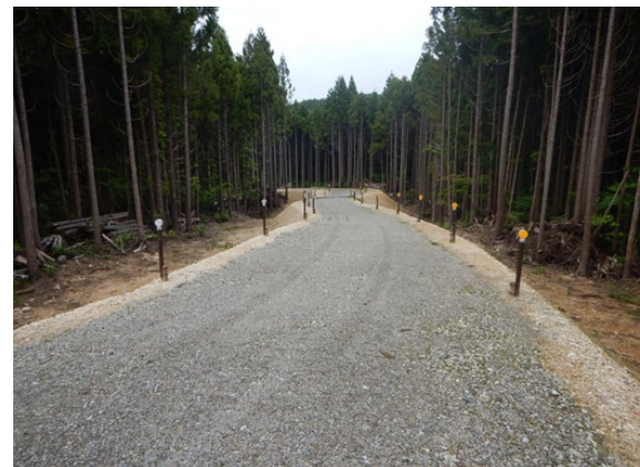
視線誘導標 (青森県五所川原市) [国有林林道事業]
