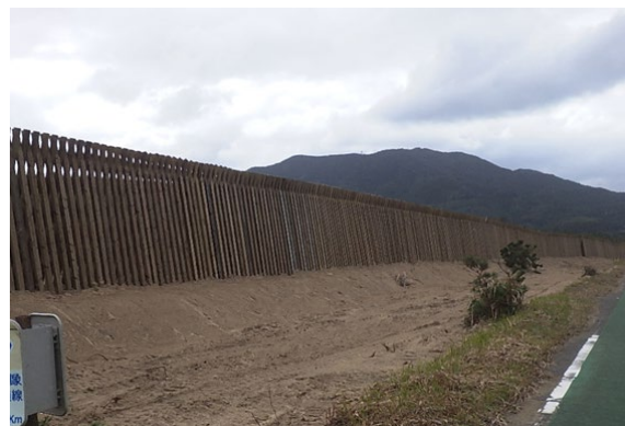
防風柵（福岡県遠賀郡岡垣町） [国有林治山事業]
