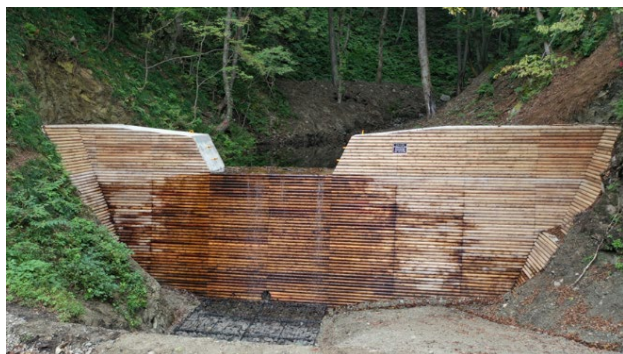
丸太材残存型枠 (福島県福島市) [国有林治山事業]
