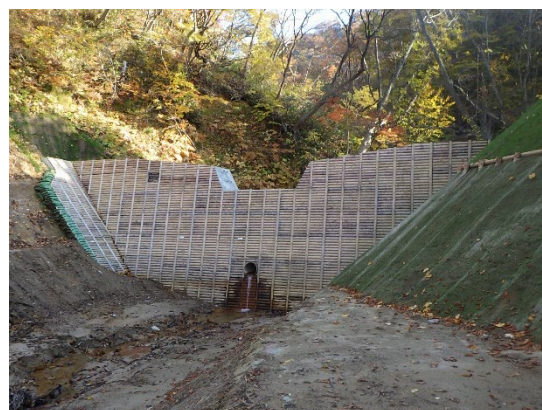
パネル式残存型枠 (山形県最上郡戸沢村) [国有林治山事業]
