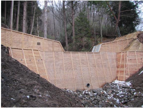
パネル式残存型枠（岩手県宮古市） [民有林治山事業]
