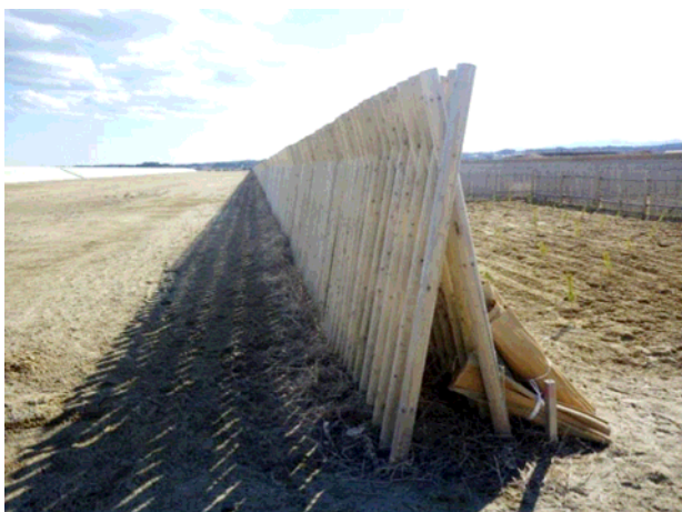
丸太防風柵（福島県相馬市磐城森林管理署管内） 〔海岸林造成工事国有林治山事業〕
