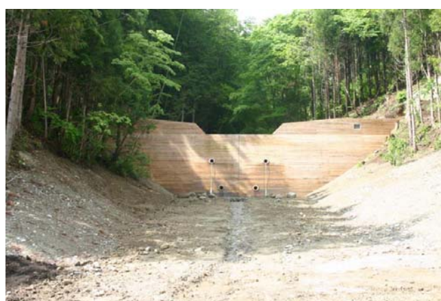
残存型枠工 (栃木県日光市日光森林管理署管内) [災害関連緊急事業]
