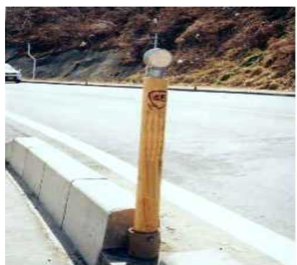
視線誘導標の例
