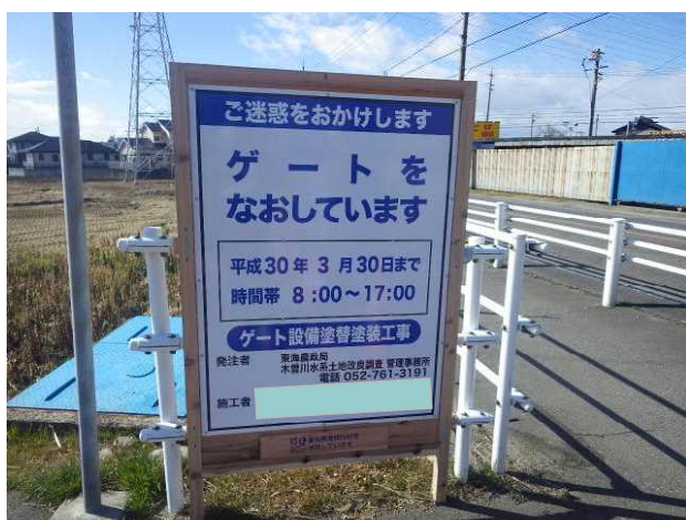
工事用看板（愛知県一宮市浅井町） [ストックマネジメント技術高度化事業]
