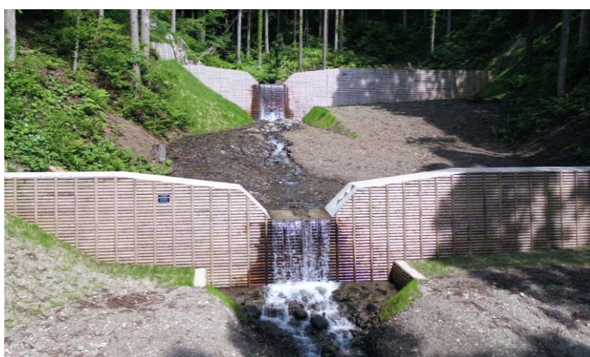
残存型枠工 (秋田県大仙市) [復旧治山事業]
