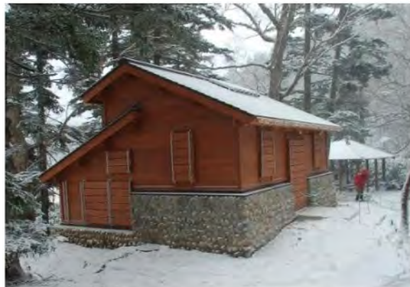
(志賀山周回線歩道公衆トイレ)
