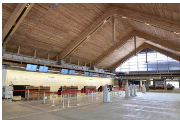
下地島空港（沖縄県石垣島） [次世代林業基盤づくり交付金]
