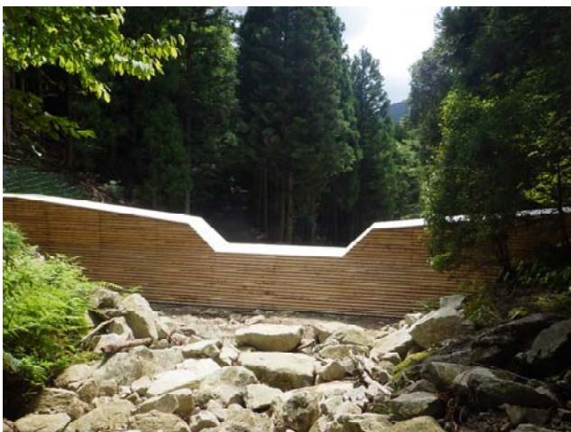
丸太残存型柵（三重県熊野市） 〔国有林治山事業〕
