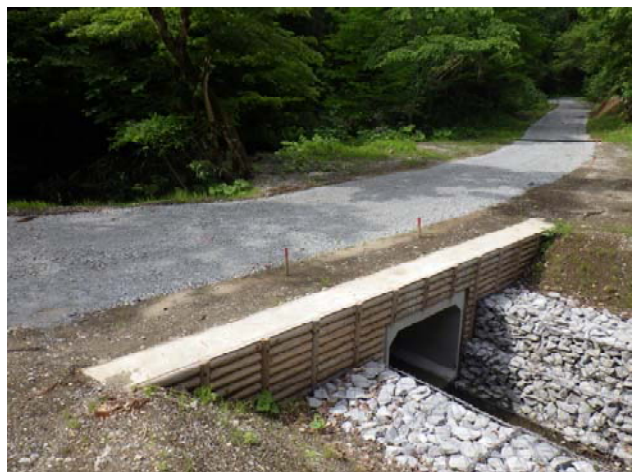
木製残存型柵（秋田県五城目町） 〔林業専用道整備事業〕
