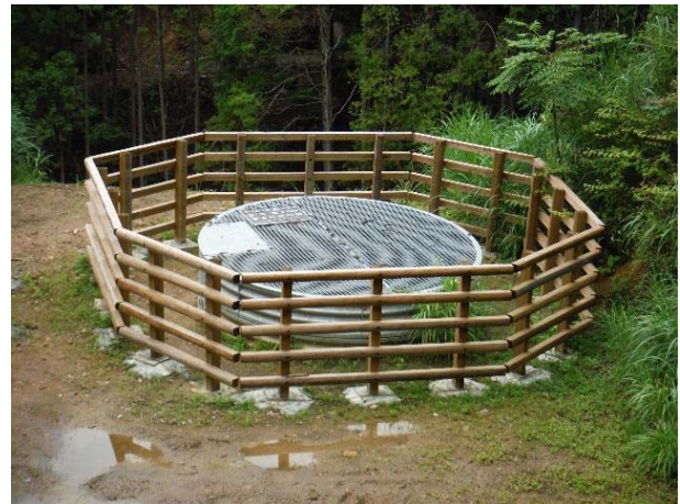
集水井防護柵（奈良県宇陀郡曽爾村） 〔民有林補助治山事業〕
