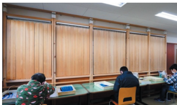
写真24 壁面木質化でのハンダ作業
