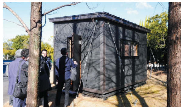
写真16 内部木質化ユニット
