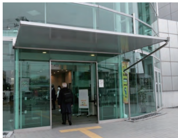
写真11 エントランス庇
