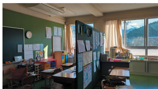
写真1 ひまわり教室の施工前風景
