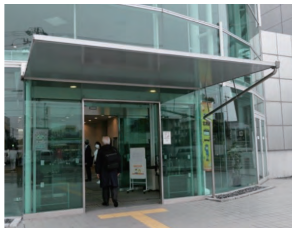
写真11 エントランス庇
