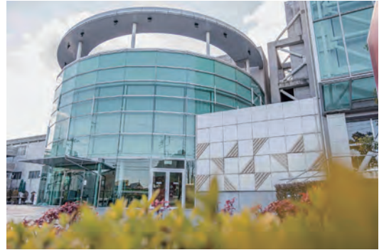
写真4 桑名市民会館外壁（木質化後）
