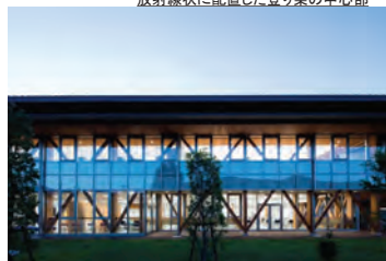
カーテンウォール越しに柱・筋交いが視認できる
