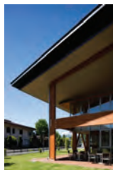
軒を深く露出した柱・梁
