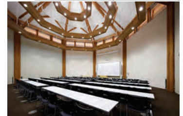
2本の登り梁を露出した架橋
