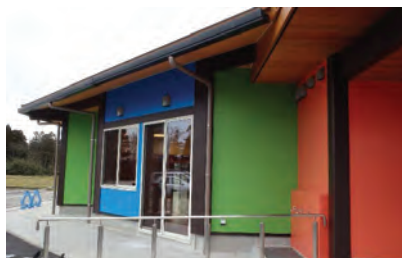
軒の設置状況
