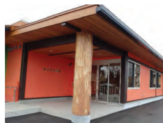
玄関の柱にもスギ丸太柱を採用
