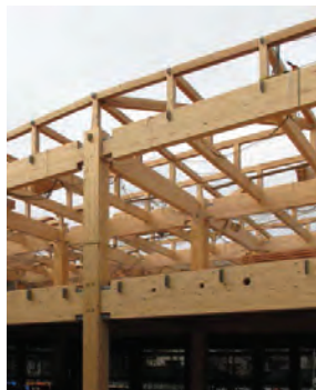
建方中の構造フレーム
