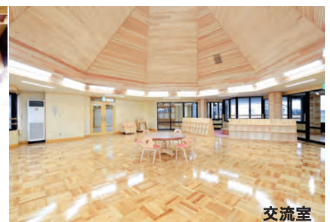
製材を組み合わせた「組梁」とRCスラブ
