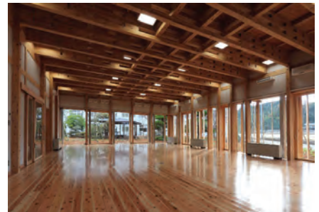
写真1: 視聴覚室(合せ透かし梁スパン9m)
