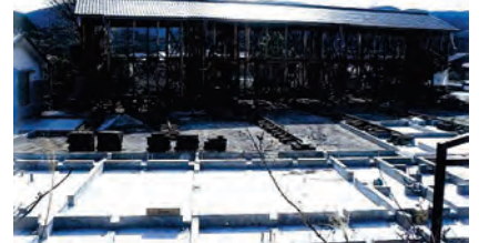
曳き移転工事状況 (基礎工事完了時点)
