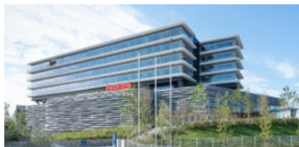
①岩谷産業神戸研究所 (2024年10月竣工) (上層4層の外周柱梁が木造)
