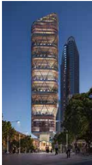
②キャプションby Hyatt兜町東京 (2025年7月竣工) 撮影 エスエス (3～12階の柱・梁の一部が木造)
