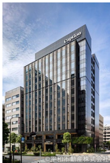
②キャプションby Hyatt兜町東京 (2025年7月竣工) 撮影 エスエス (3～12階の柱・梁の一部が木造)
