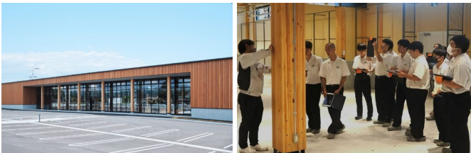
新たに竣工した無印良品 日田店 地元の高校生を対象にした見学会
