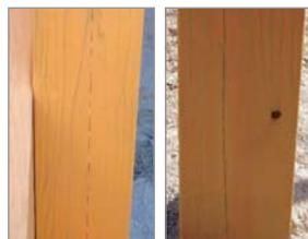
写真6 干割れが発生した柱 (山側の空中デッキ柱)
