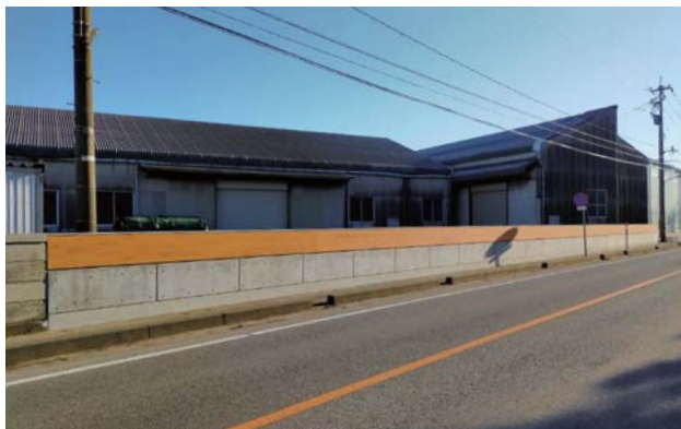
完成時（令和4年2月）
