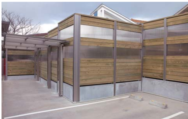
完成時（令和4年1月）
