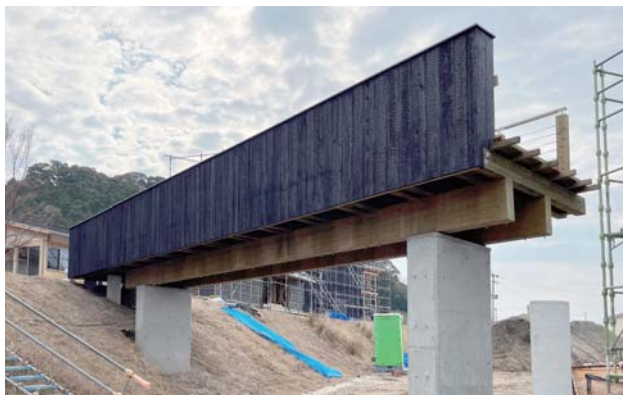
完成時（令和5年1月）
