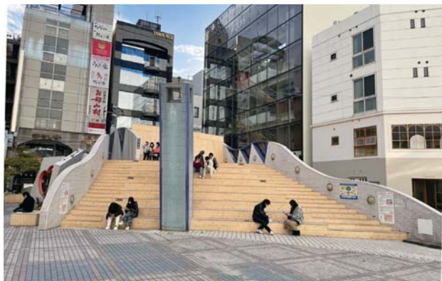
完成時（令和4年12月）
