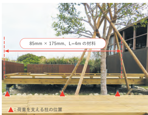
写真 10-2 大きな断面の木材を利用し、荷重を支える柱の本数を少なくしたウッドデッキの例
