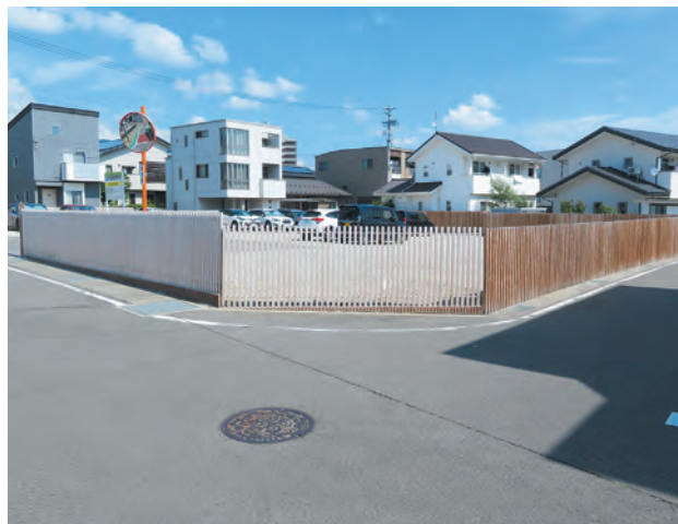
写真 9-1 工場で作られた木柵・木堀の例
