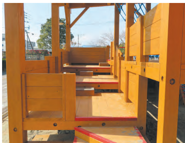
写真 14-3 ボルト接合を用いた木製遊具の例
