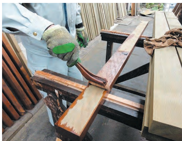
写真 11-2 工場で木製に用いる板材に木材保護塗料を塗布している例
