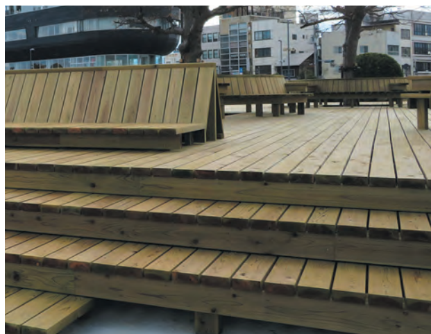
写真 1-2 デッキ床板材やベンチ等に使用する木材の断面を揃えた例
