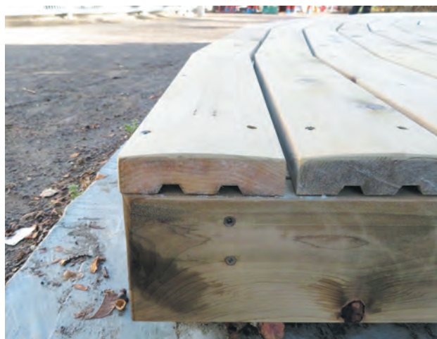
写真 4-2 床材の表面を曲面状に加工した例
