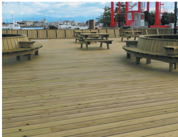
写真 14-1 床板、ベンチ等に用いる木材を住宅工事に用いる間柱に統一し、入手のしやすさや使い回しに配慮したウッドデッキの例
