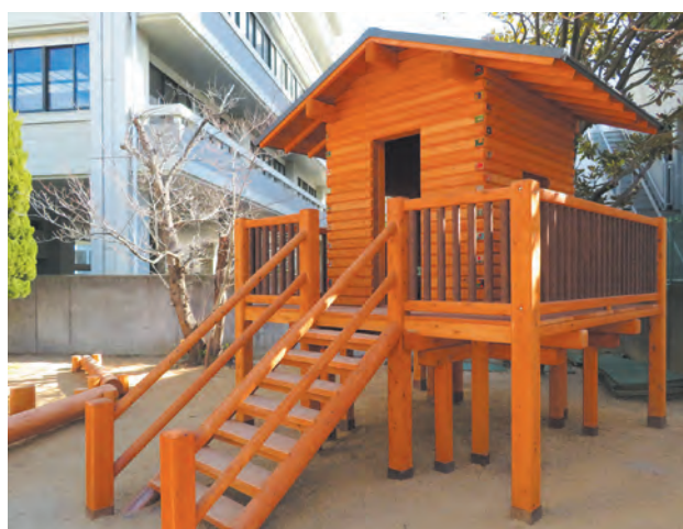
写真 2-3 明るい色調の木材保護塗料を用いた木製遊具の例
