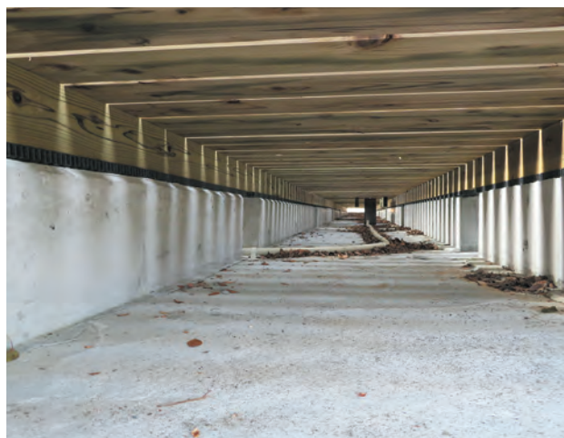
写真 4-1 通風の良いつくりとしたウッドデッキの下部の例
