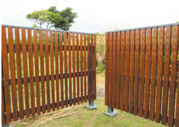
写真 7-2 柱に鋼材を利用した木柵の例
