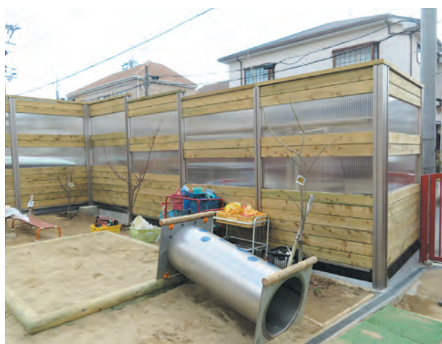
写真 9-3 アルミ材を用いた柱間に落とし込み板とした木堀の例
