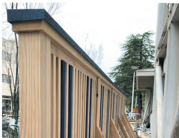
写真 6-3 板金で上部を保護した自転車置き場の例
