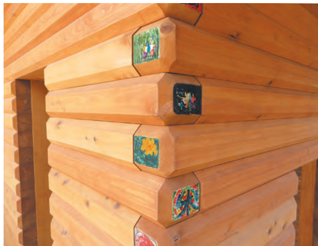
写真 8-1 木材の角を曲面状に加工し、利用者の安全性に配慮した木製遊具の例
