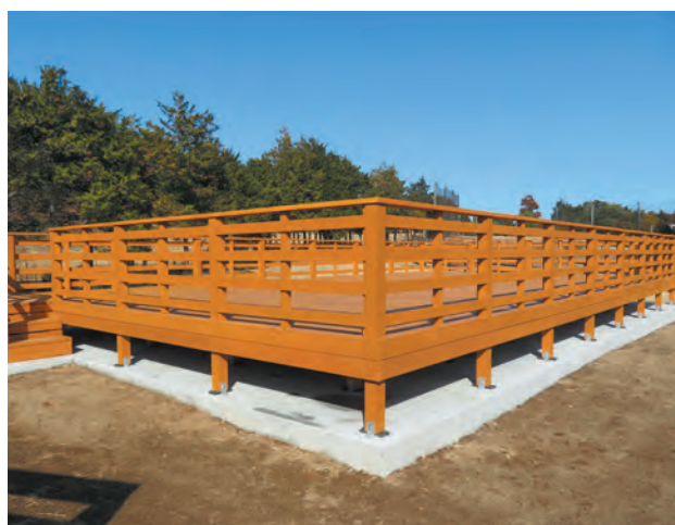
写真 3-2 コンクリート面に束を用いるタイプのウッドデッキの例
