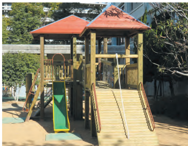
写真 13-1 下部や屋根面等の確認が容易となる開放的なつくりとした木製遊具の例
