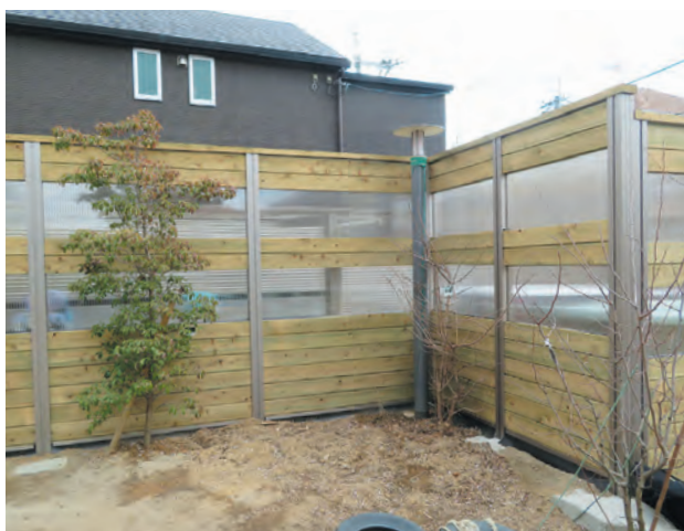
写真 7-3 アルミ製の柱を用いた木塀の例
