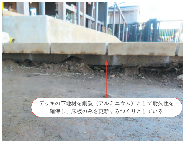
写真 7-1 鋼製の下地材を用いたデッキの例
