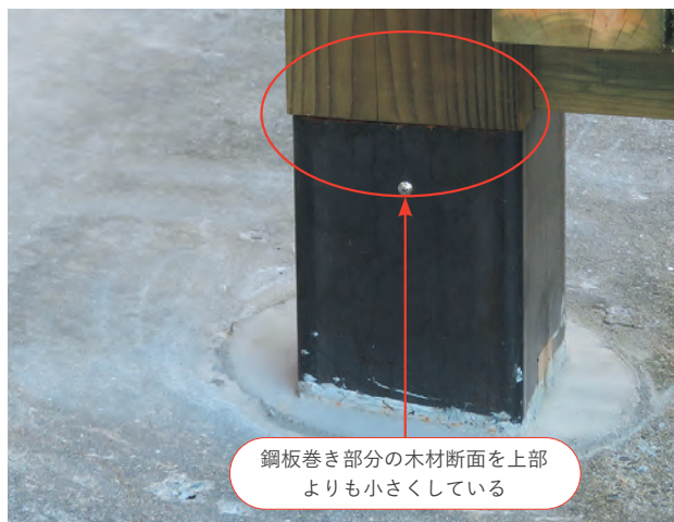
写真 5-1 鋼板巻き部分の木材断面を小さくして雨水等の浸入を防いでいる柱脚部の例
