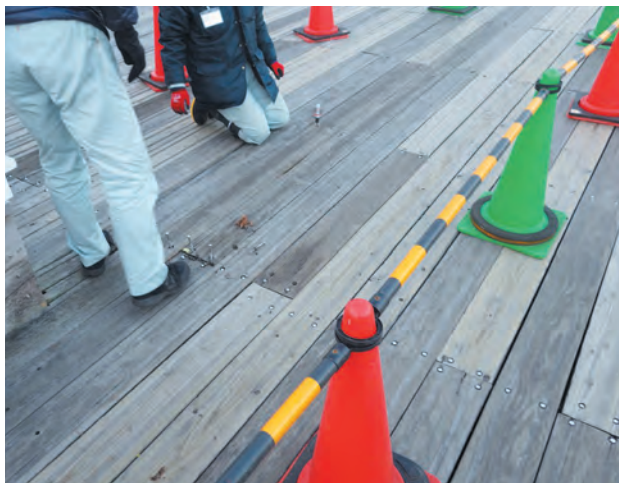
写真 15-1 ウッドデッキ床板材や下地の状況を確認するため、接合具を外している様子
