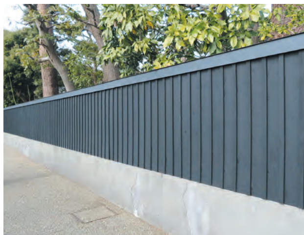
写真 2-2 濃い色調の木材保護塗料を用いた木塀の例
