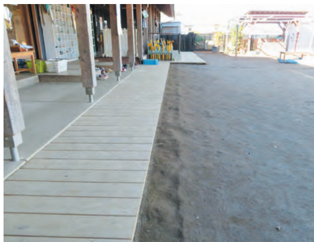
写真 14-2 一般に流通している規格の木材を利用したウッドデッキの例
