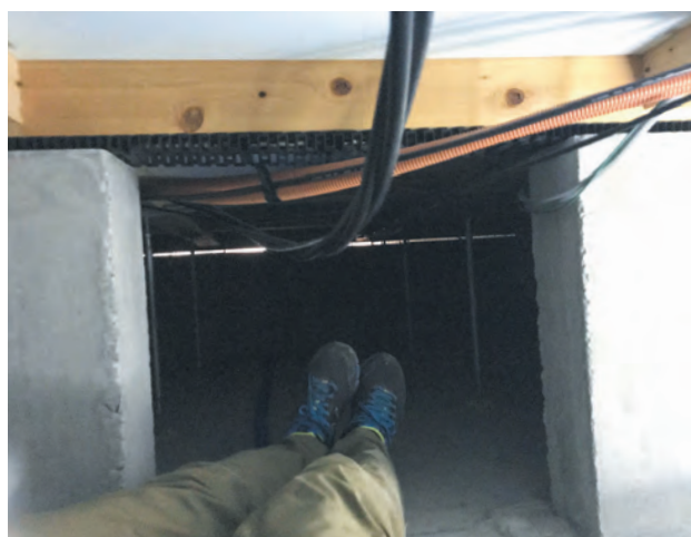
写真 13-3 戸建て住宅の床下部の基礎立ち上がりに設けた人通口の例
