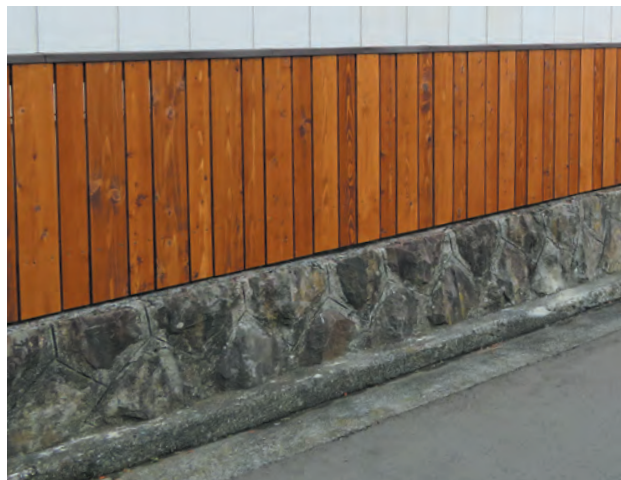
写真 2-1 含浸形の木材保護塗料を塗布した例
