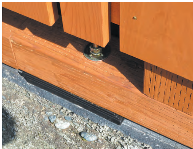
写真 1-1 加圧注入処理を施した木材を土台や柱に用いた木塀の例
