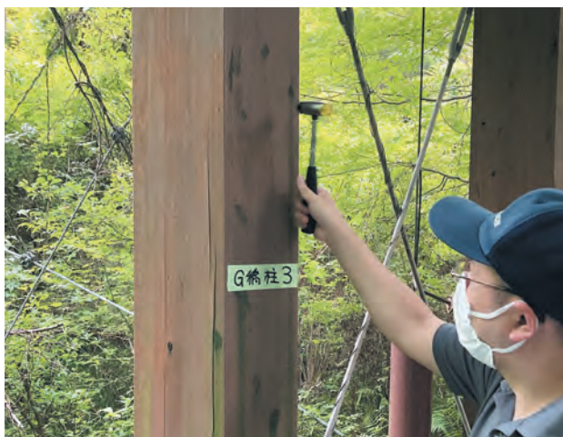
写真 15-2 専門家による点検の様子
