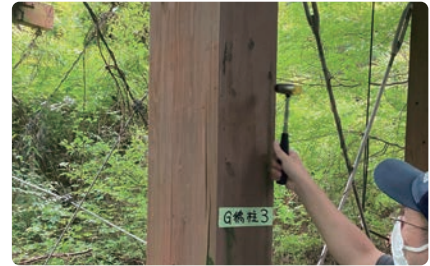
打診により木材内部の状態を確認している様子
