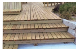
使用木材の断面は 120mm×45mmに統一
