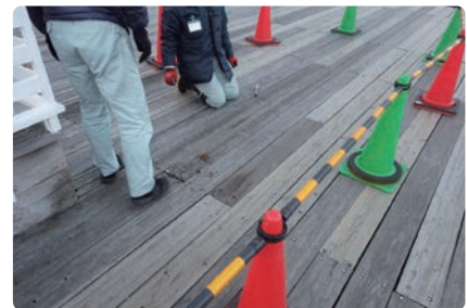
ウッドデッキ床板材や下地の状況を確認するため、接合具を外している様子
