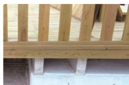
デッキ下部はRC造ベタ基礎
